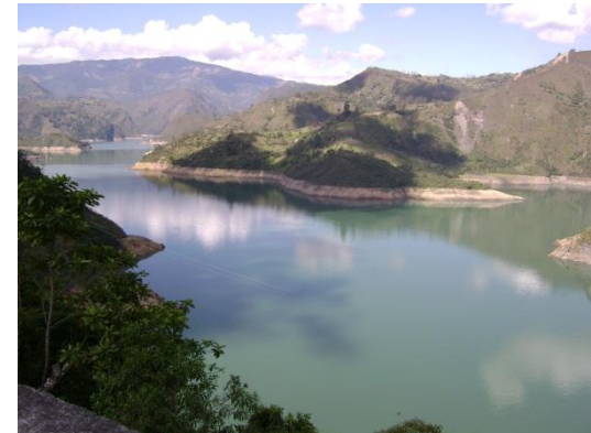
Central Hidroeléctrica Del Guavio
